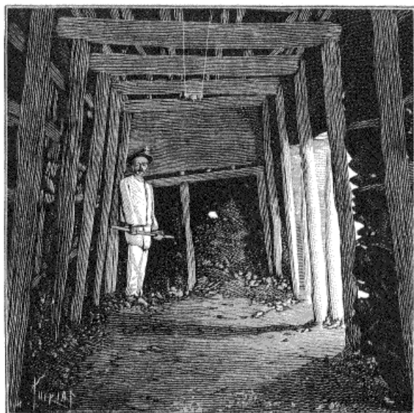
Fig. 2. — Galerie boisée dans la mine de houille.
